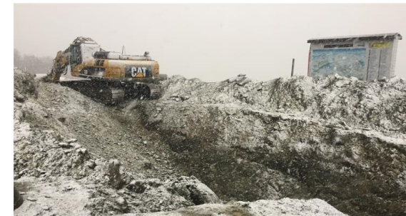
Arbeidsulykka skjedde under gravearbeid i skiseretret i Vangslia. FOTO: TORE MEIRIK
